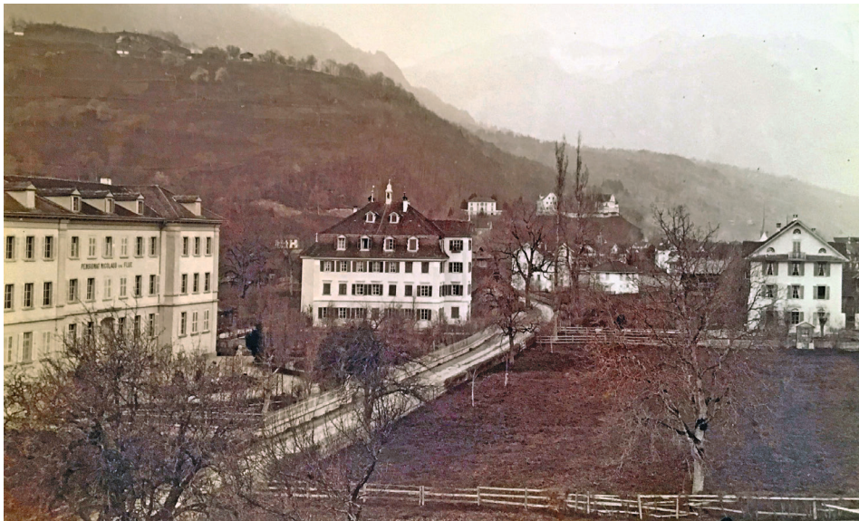
ABB. 4: Die Sarnen Schule, wie sie beim Eintritt von Franz Xaver Scherer 1888 noch ausgesehen hat. Links das Konviktsgebäude, in der Mitte das Alte Kollegi, wo die Mönche wohnten. Rechts im Bild das im Jahr 1870 erbaute Schössli, das 1928/29 dem neuen Professorenheim angegliedert wurde. (Foto: StiAMG Sarnen)
