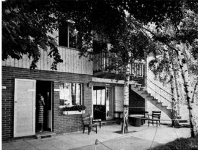
Abb. 122: Landwirtschaftliches Bauamt Brugg/Verena Fuhri-mann-Weber, Neu-hof, 1958, Zweite Schweize-rische Ausstellung für Frauenarbeit Zürich. Die Vorderansicht zeigt den mit Backsteinen gemauerten Sockel des Bauernhauses.
