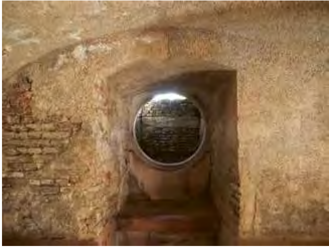
Abb. 74: Blick auf eine der Fensternischen im Kellergewölbe des Minervatempels.
