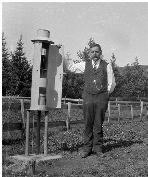
*Abb. 35: Vorrichtung zur Bestimmung der Niederschlagsmenge. Das abgebildete Modell wurde in den 1890er-Jahren von den meisten offiziellen schweizerischen Messstationen verwendet.*
